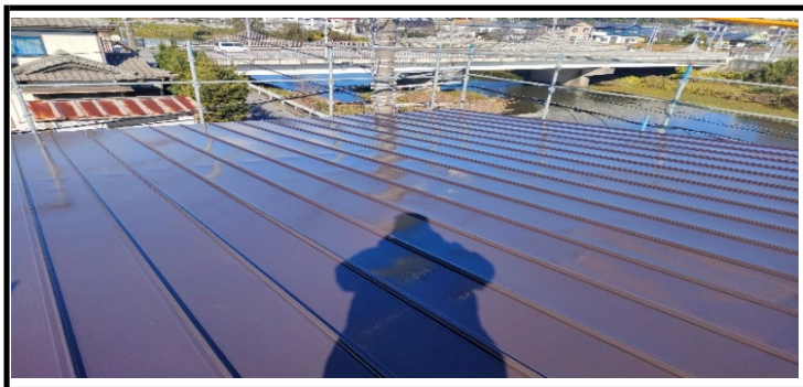
屋根は傷みが早いので高耐候性(無機塗料)
