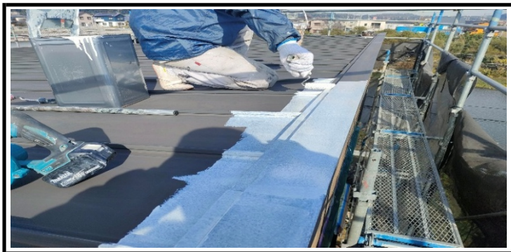
屋根は傷みが早いので高耐候性(無機塗料)
